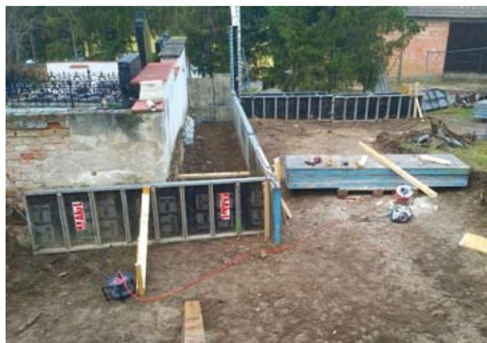
Die Fa. Hofer Profihandwerker hat bereits mit der Neuerrichtung der Betonfundamente und der neuen Einfriedung begonnen
