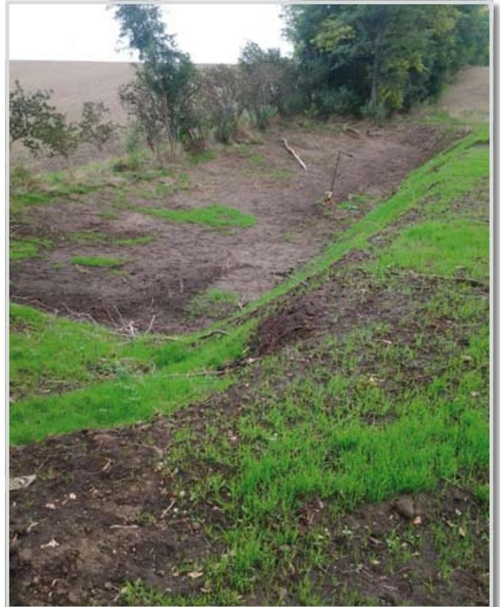
*Im Bereich des Windschutzgürtels beim Auffangbecken Kirchbergen war der Damm gebrochen, dieser wurde saniert, sodass das Wasser in diesem Bereich wieder aufgenommen werden kann.*
