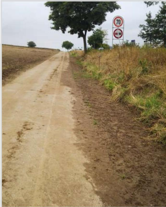
*Aufgrund der Verschlammung durch das Hochwasser mussten die Rohrdurchlässe entlang der B7, das Becken und der Güterweg gereinigt und ausgebaggert werden.*
