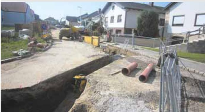
Die Sanierung des Kanals, der Gasleitungen sowie der erforderlichen Hauswasseranschlüsse in Hoberndorf (Hubertusgasse, Kreuzgasse) konnte Ende August abgeschlossen werden. Es wurde eine provisorische Verschließung der Grabungskünetten hergestellt. Im kommenden Jahr soll die endgültige Asphaltierung erfolgen.
